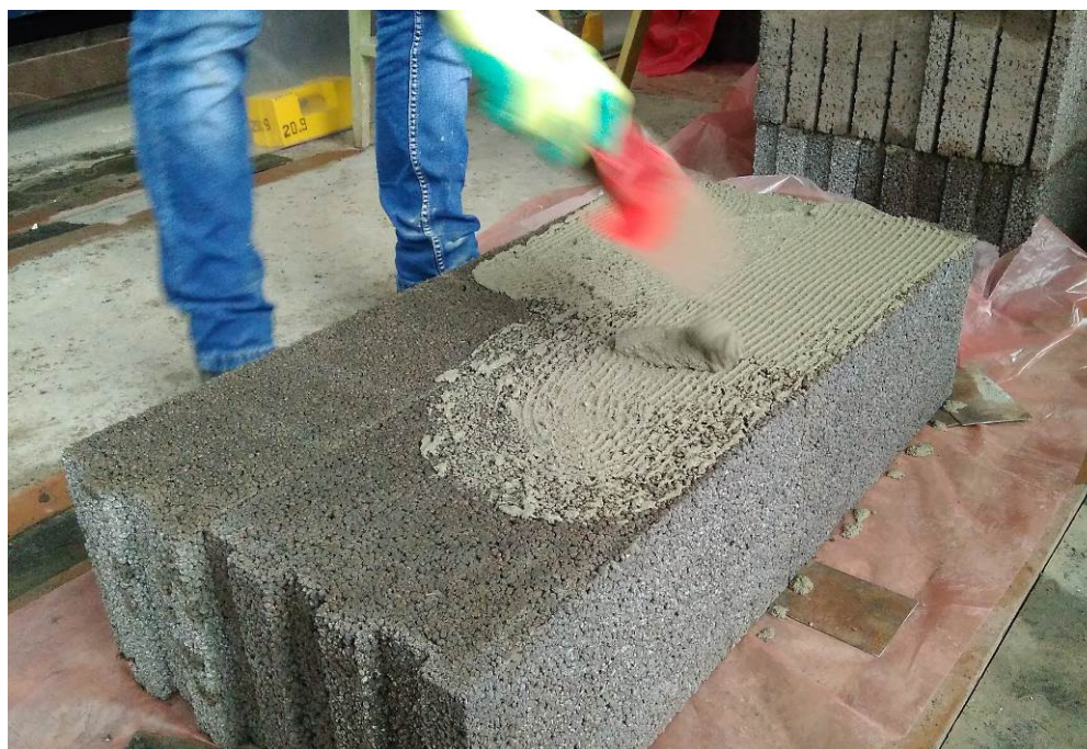
Рисунок 5.1 – Нанесение кладочного раствора на поверхность блока
